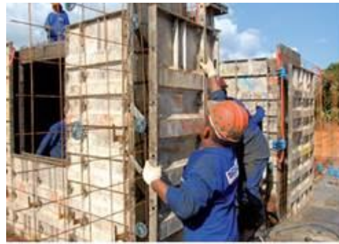
Figura 3 – Montagem de formas para concretagem
