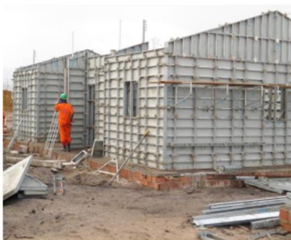
Figura 20 – Formas prontas para receber concreto
