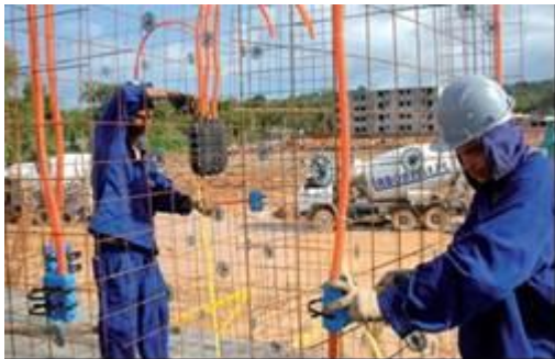
Figura 2 – Execução da instalação elétrica na parede de concreto
