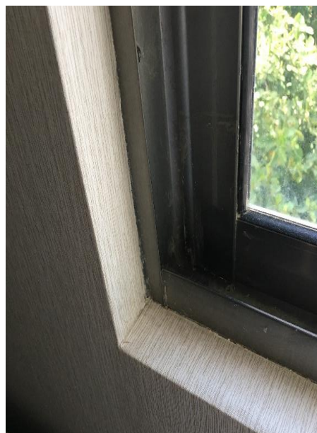
Figura 92 – Detalhe do revestimento de papel de parede dos quartos
