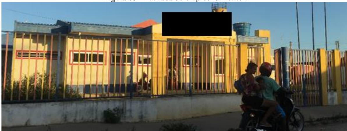
Figura 75 - Fachada do empreendimento D
