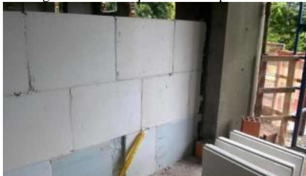
Figura 11 – Execução das fiadas posteriores
