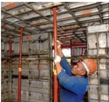
Figura 4 – Execução do escoramento das formas
