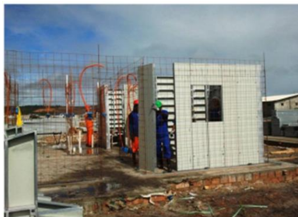
Figura 19 – Armação das paredes prontas com colocação das formas
