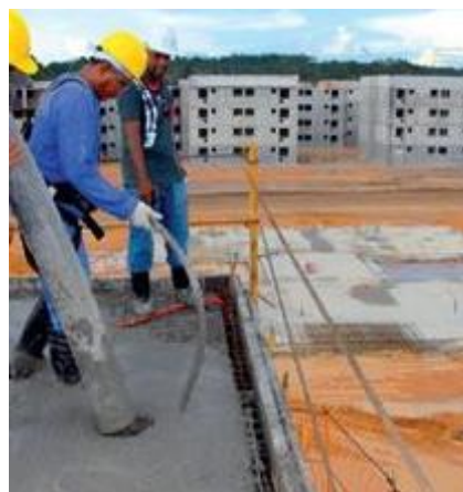
Figura 5 – Concretagem de paredes e laje
