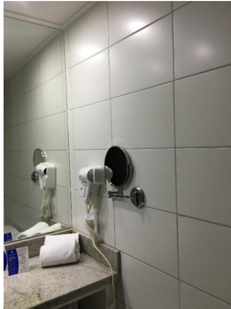
Figura 93 – Vista do revestimento cerâmico dos banheiros dos quartos
