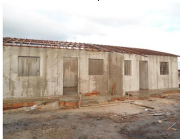
Figura 21 – Paredes concretadas com estrutura da cobertura pronta
